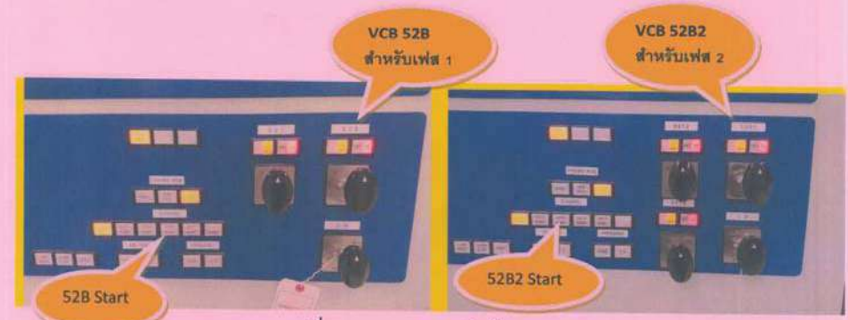
รูปที่ 1 แสดงสถานะของสวิตช์ VCB 52B, VCB 52B2
